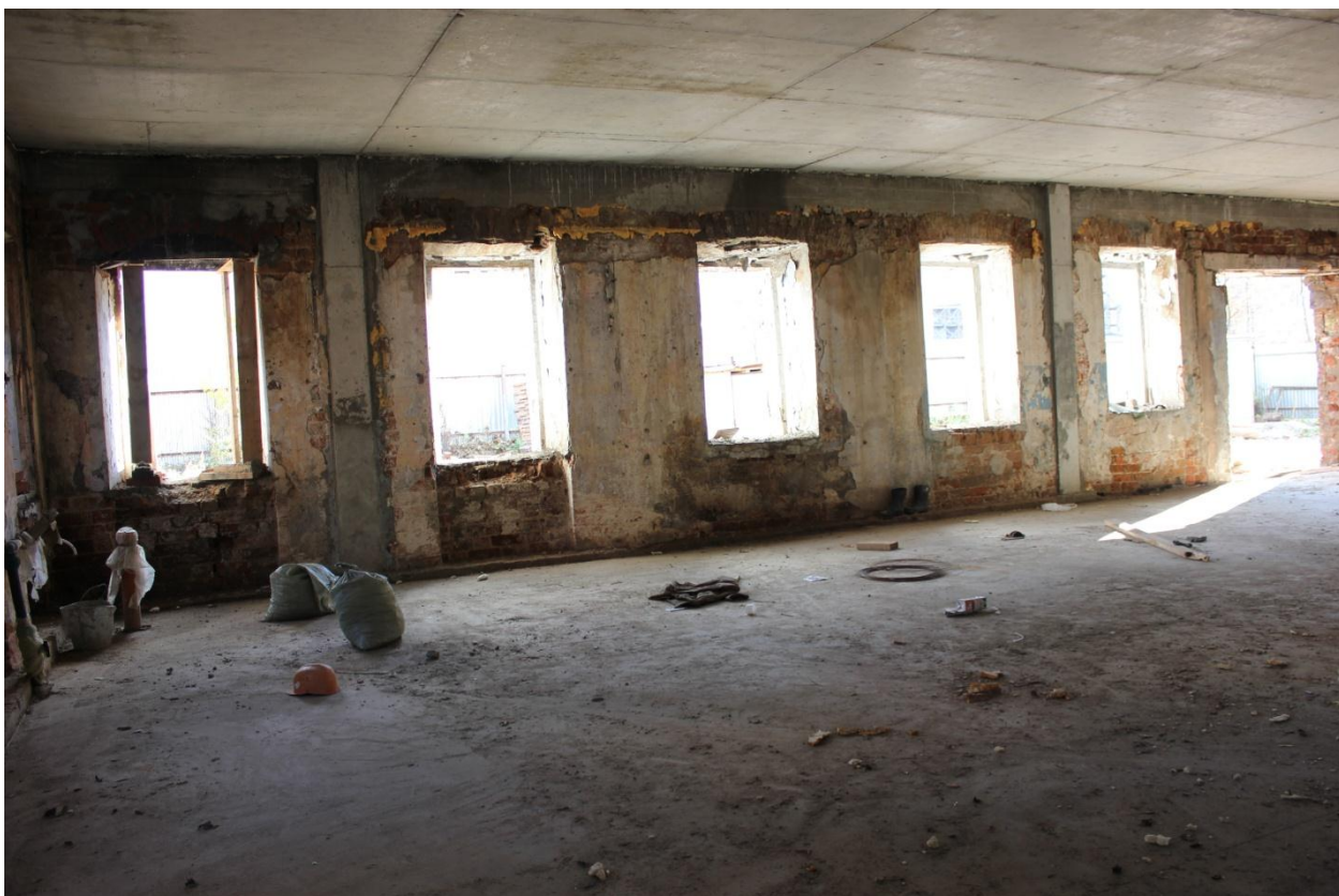
Фото6. Внутреннее состояние объекта 2018г.
