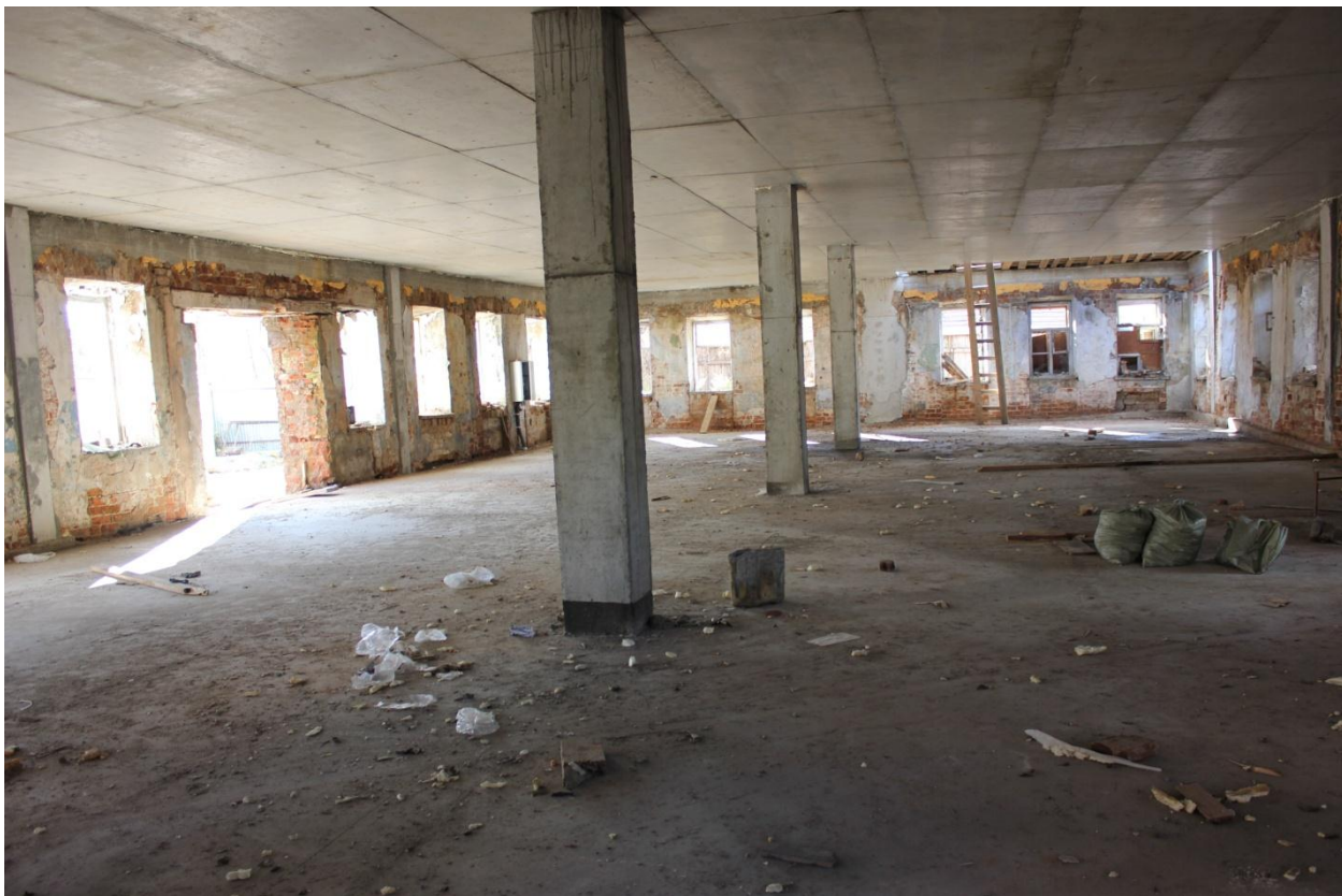
Фото5. Внутреннее состояние объекта 2018г.
