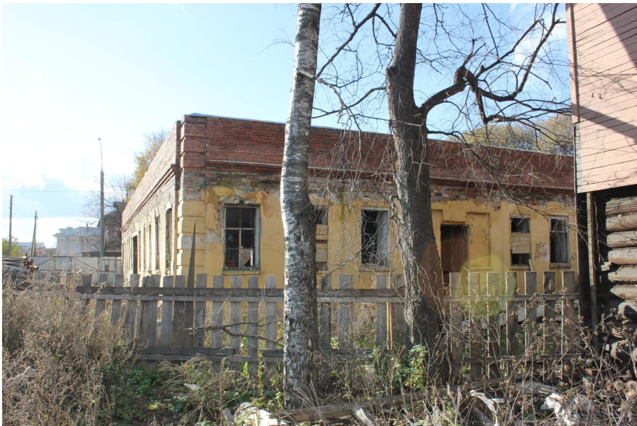
Фото3. Фрагмент северного фасада, 2018г.
