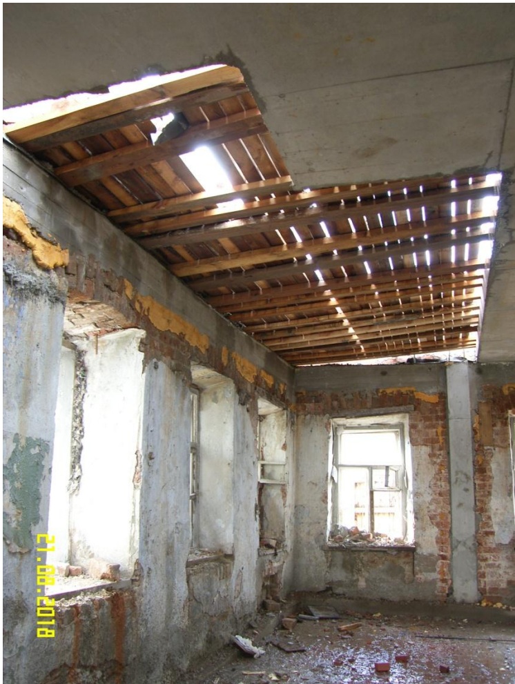
Фото7. Состояние перекрытий 2018г.
