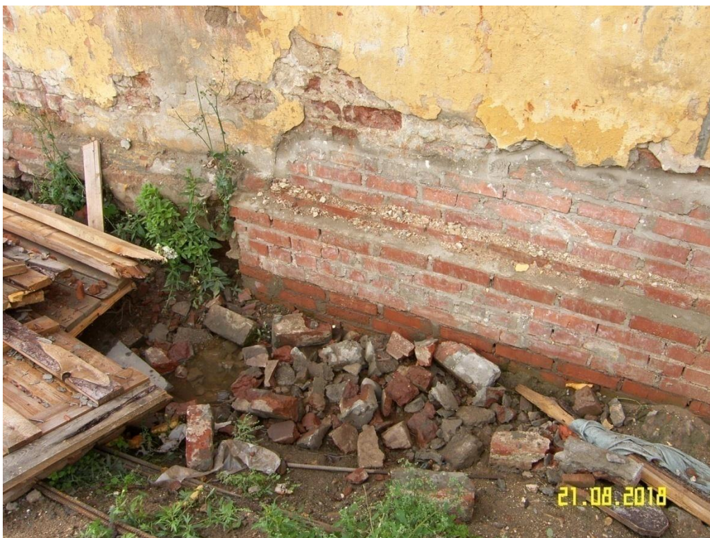
Фото8. Состояние цокольной части и стен 2018г.
