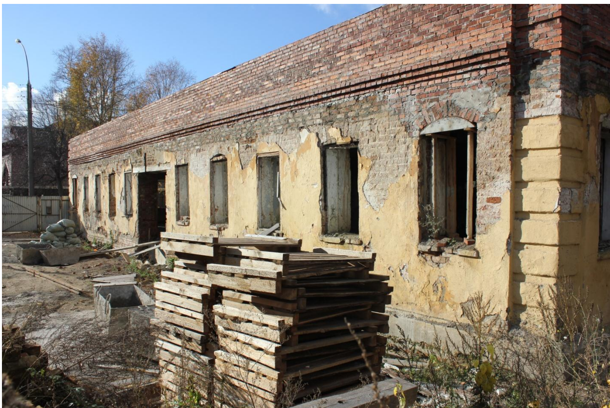
Фото4. Восточный фасад, 2018г.
