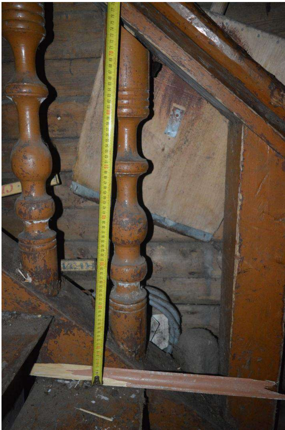
16. Балясена дворовой лестницы, 2016 г.
