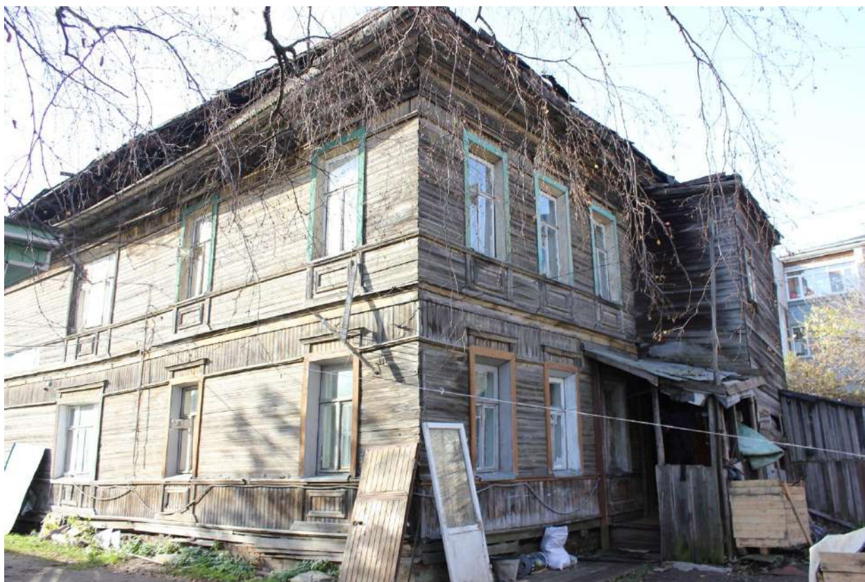
5. Северо-восточный фасад, 2018 г.
