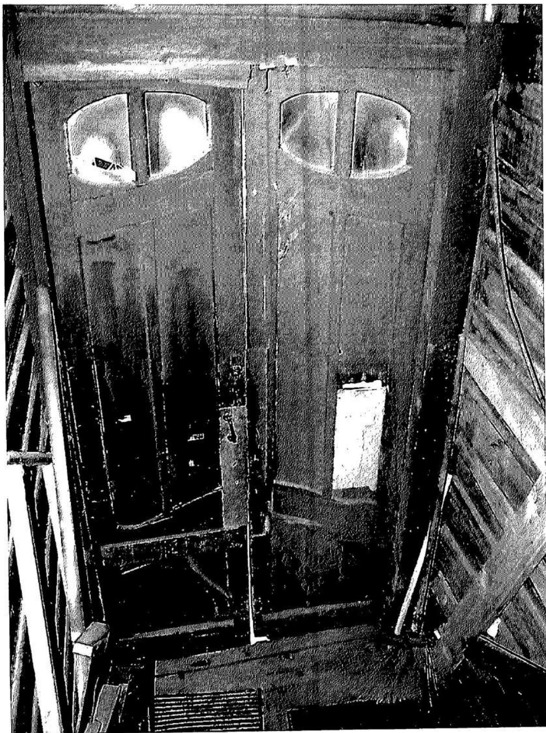
Рис.15. Дом Боголепова. Парадные входные двери, вид с лестницы (фото О. Малютиной).
