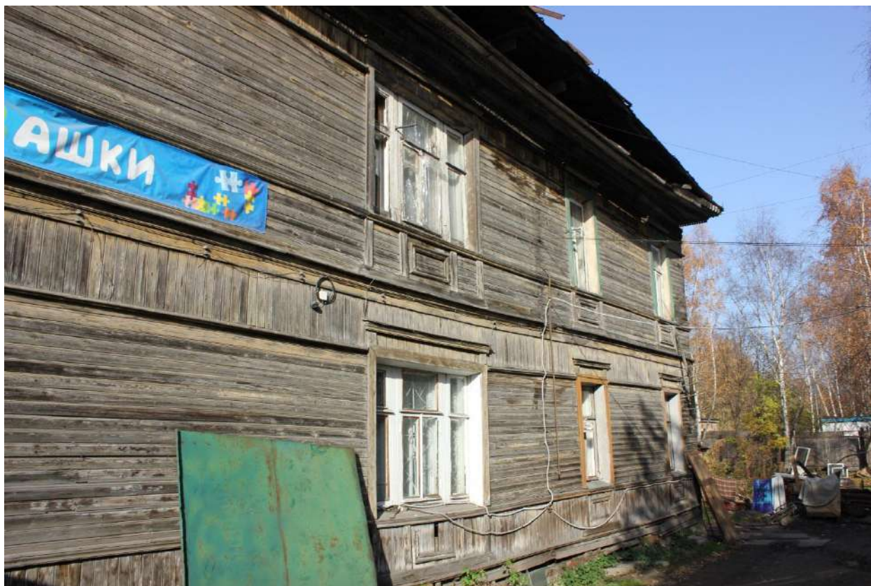
6. Восточный фасад здания, 2018 г.
