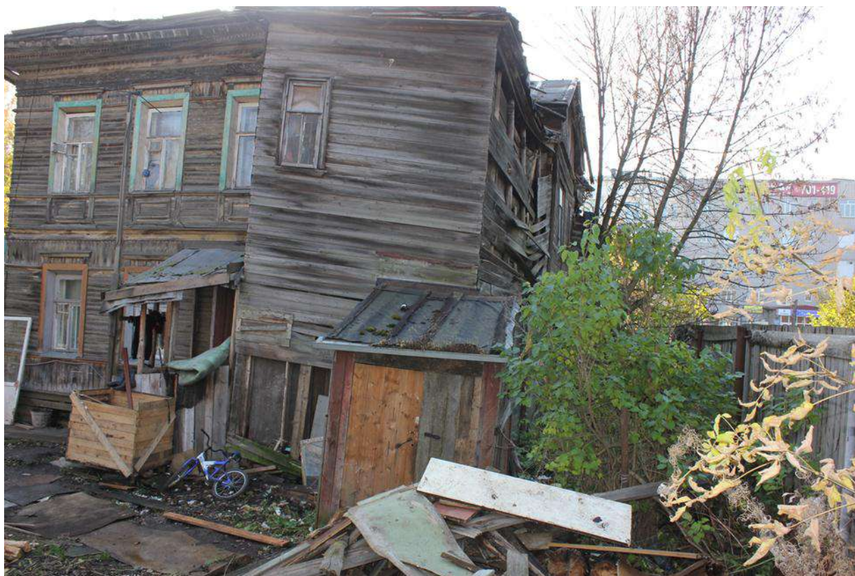
7. Северный фасад здания, 2018 г.
